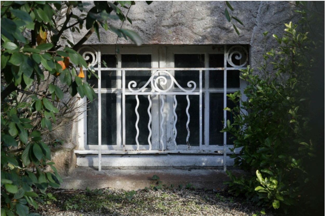
Fenêtre du sous sol.
