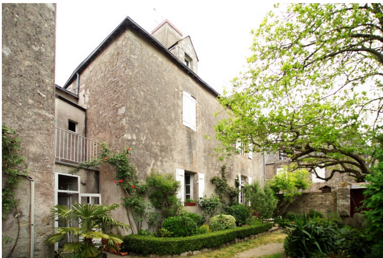
Vue d'ensemble vers l'Ouest.
