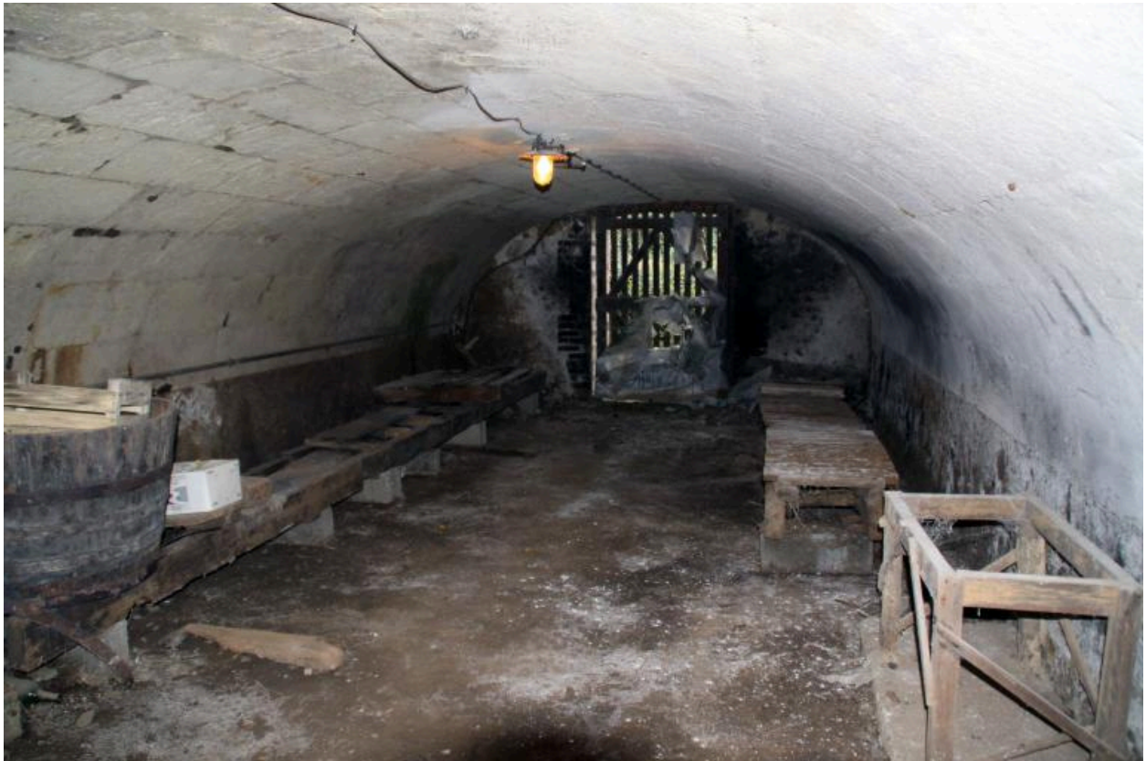
Hangar proche de la vieille maison : cave voûtée en anse de panier, en pierre de taille (1883).
