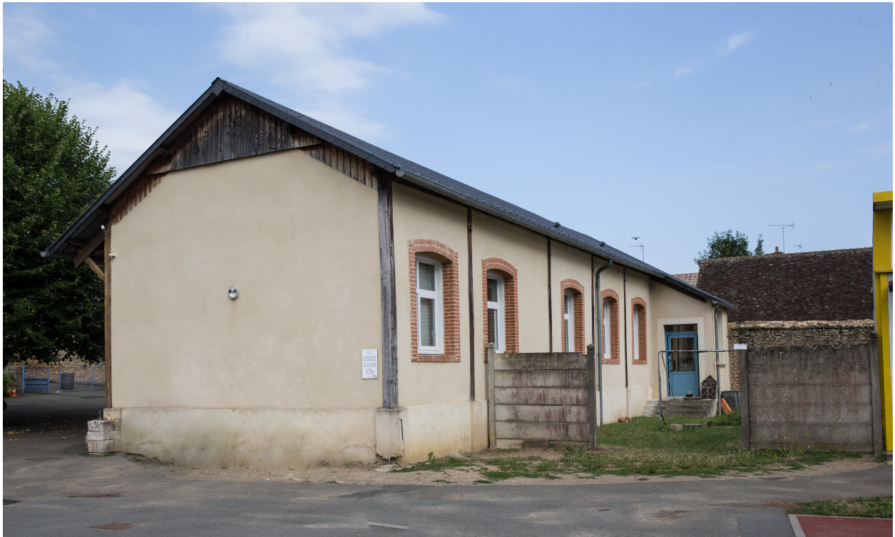
Le bâtiment des classes dans la cour.
