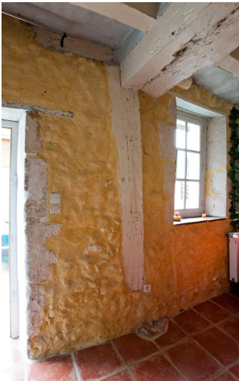
Maison, chambre à feu : poteau de bois noyé dans la maçonnerie.
