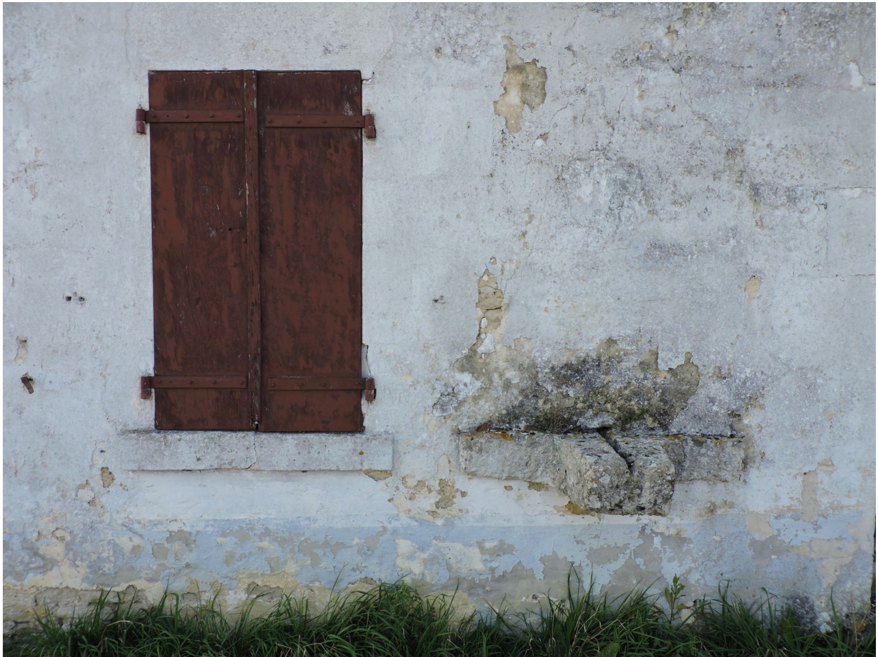
Baie et pierre d'évier d'un des logements.
