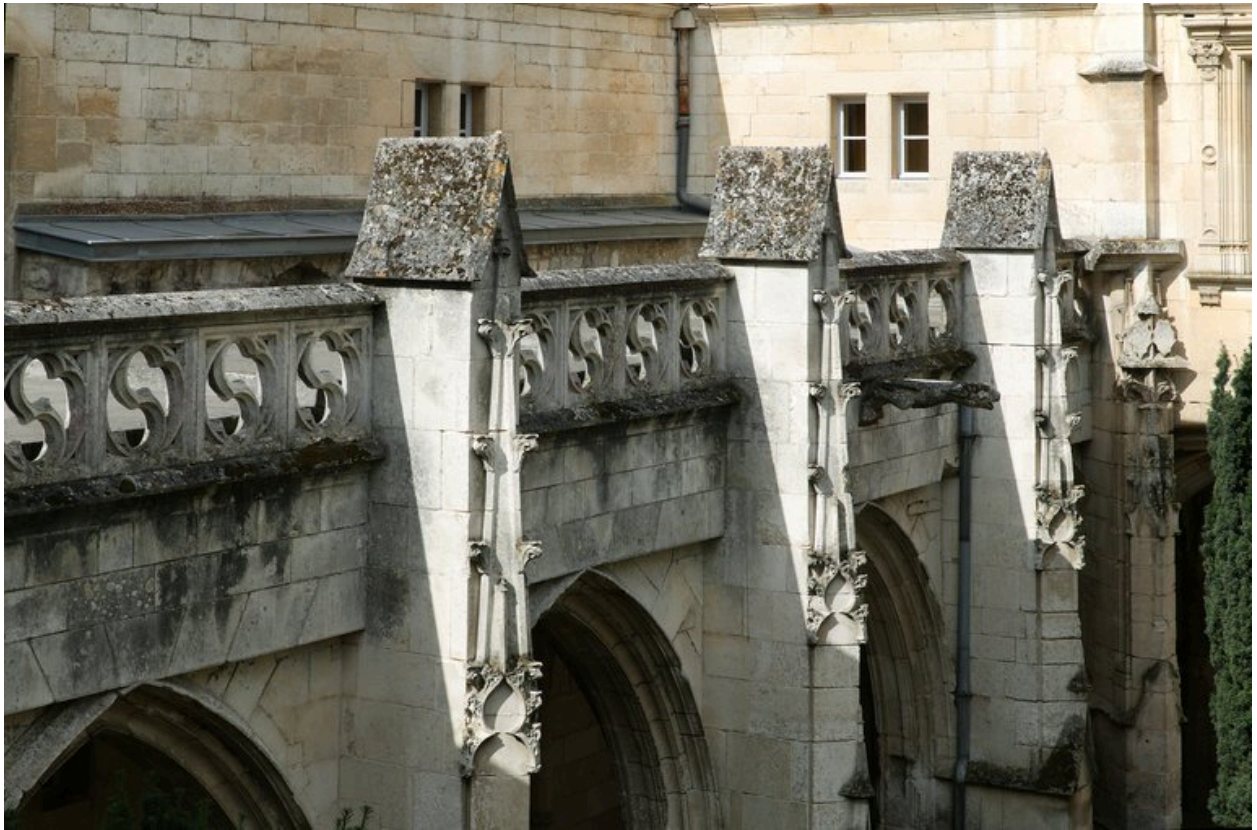
Aile sud du cloître : vue de la partie ouest, montrant les vestiges du mur nord de l'ancien réfectoire médiéval (en partie masqué par le garde-corps).
