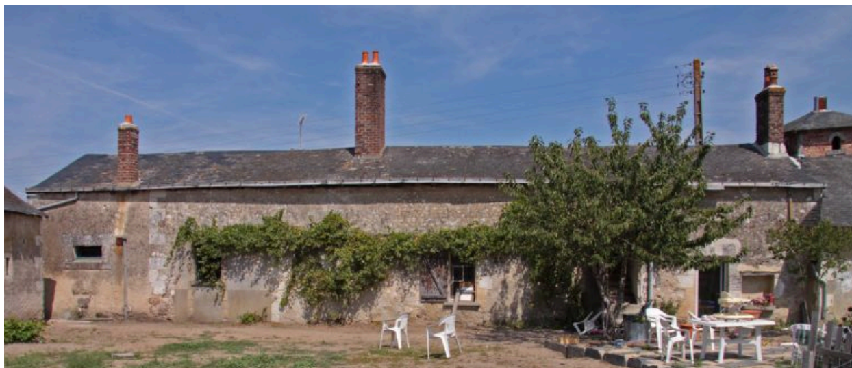
Petit Malidor : corps de logis, vue de l'arrière.
