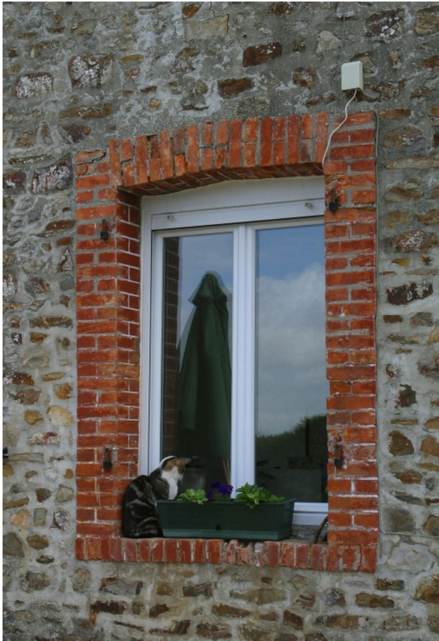
Détail de la façade principale du logis : une fenêtre.
