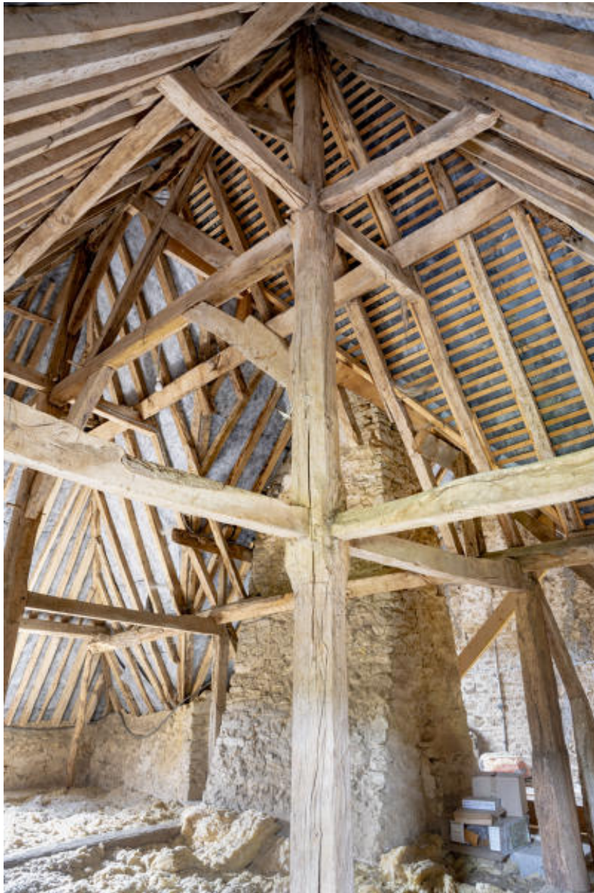
La charpente du pavillon.
