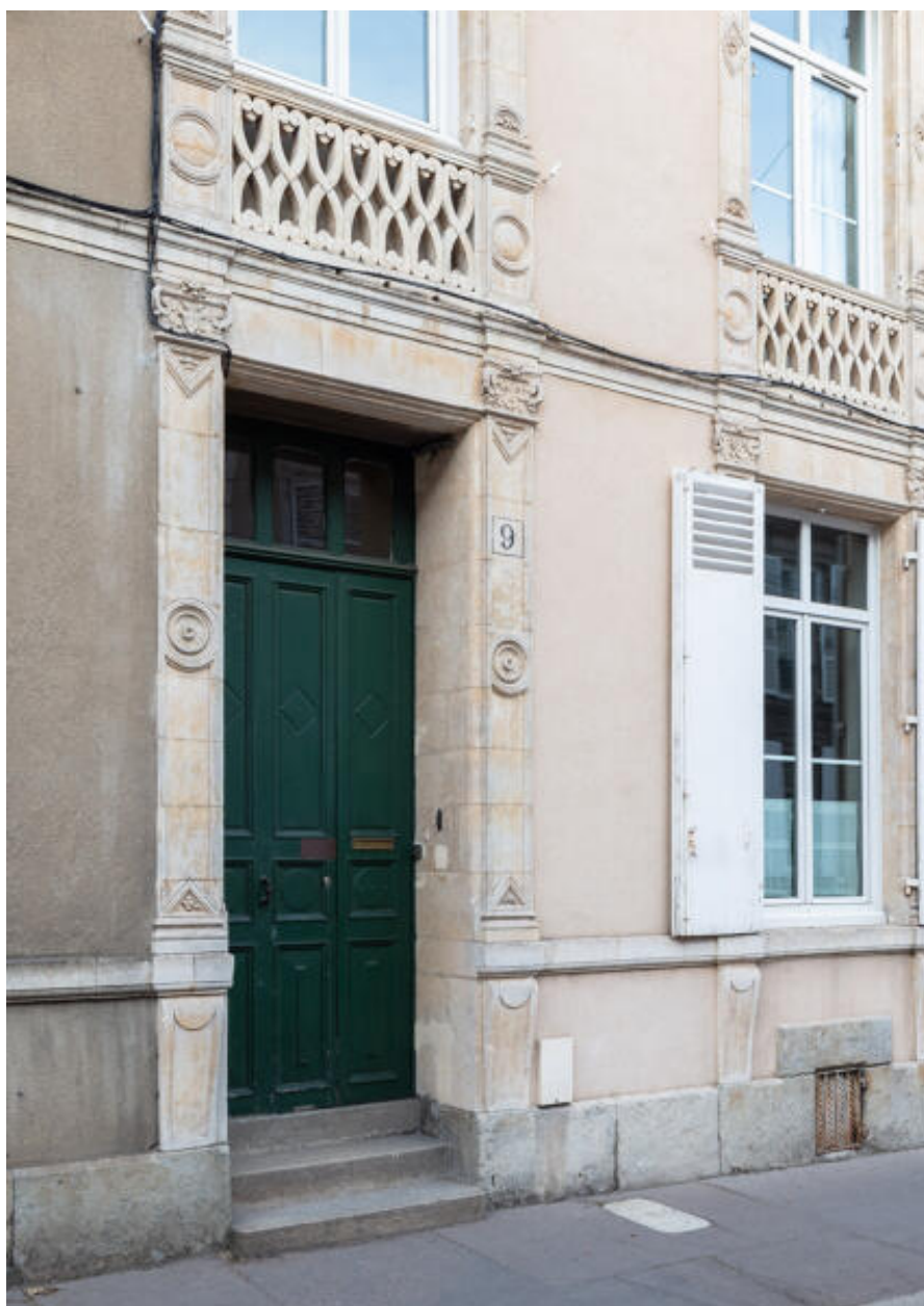
Vue du rez-de-chaussée des deux travées sud de la maison.
