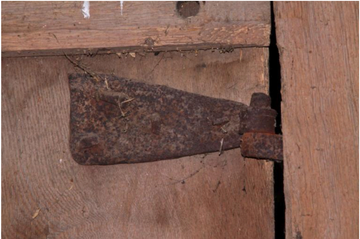
Porte de la cloison du comble : gond et penture supérieurs.
