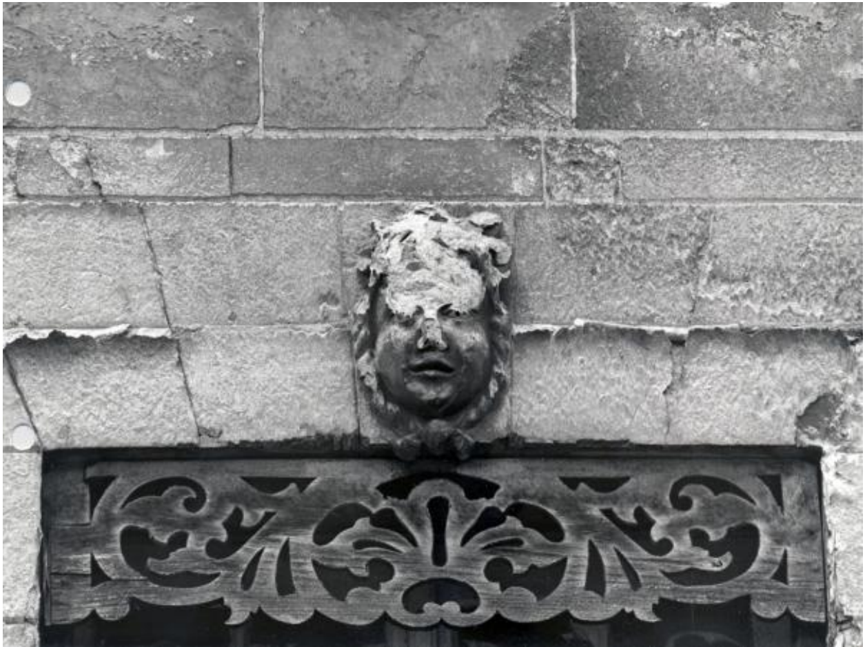
Elévation sur la rue du Canal : 1er étage, mascaron de la travée centrale.
