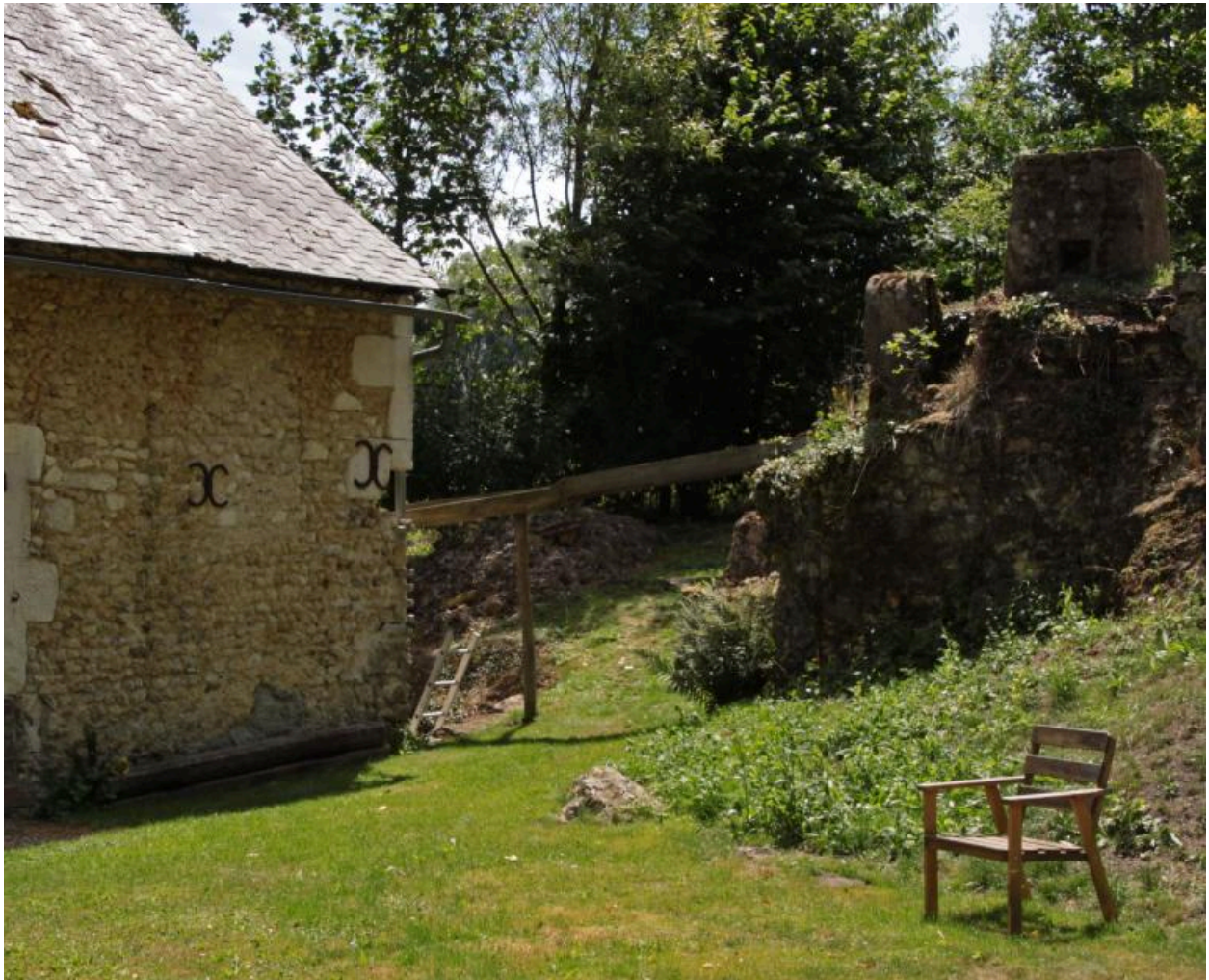
La jonction entre le moulin et le bief.
