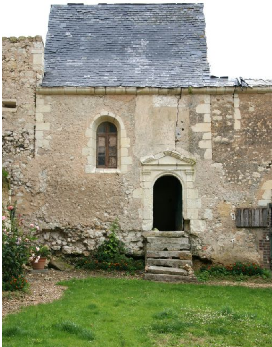
La chapelle Saint-Louis : façade sur cour.
