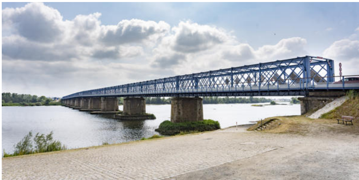
Vue générale de la cale amont.
