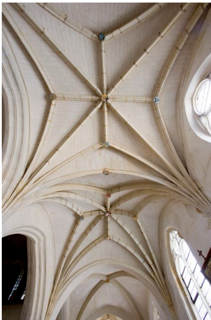
Vue d'ensemble des voûtes des travées IV et III
