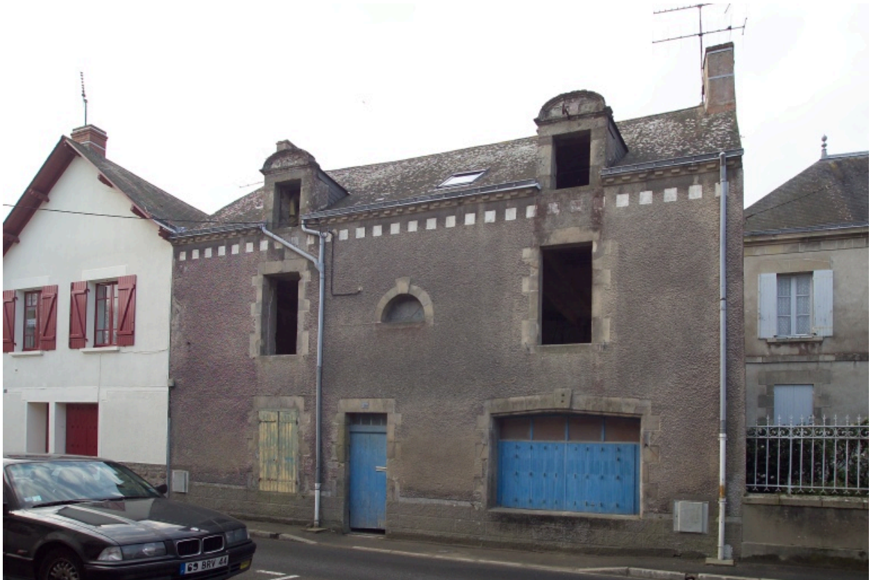
Vue de la façade sur rue.
