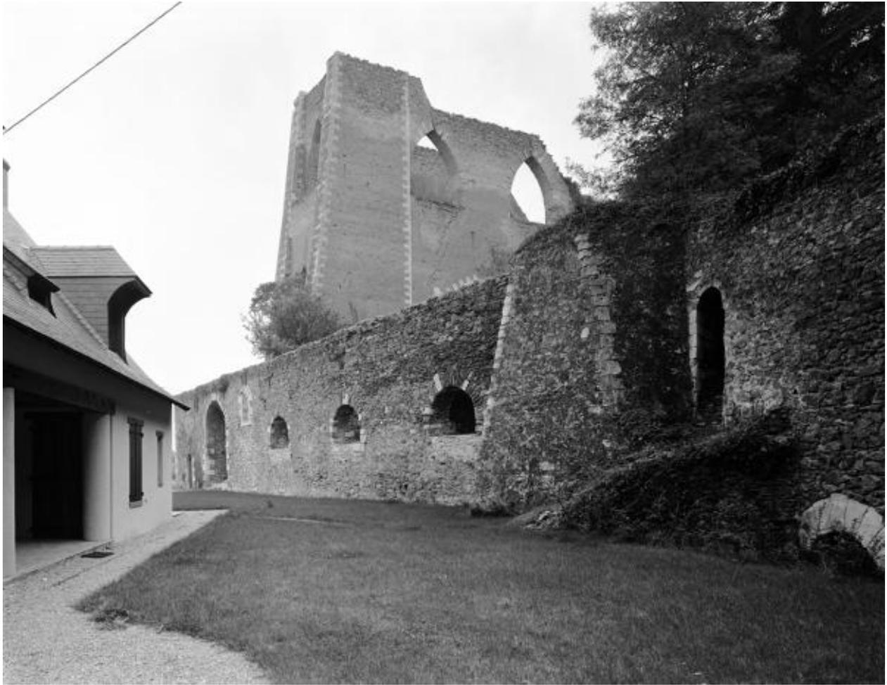
Mur de soutènement de la première terrasse, à gauche, ouverture en plein-cintre du magasin à chaux, au centre, l'escalier d'accès à la première terrasse, à droite, arc d'entrée du travers-banc du XVIIIème siècle, au fond, chevalement du puits de la Tranchée, fours de la Tranchée, Montjean-sur-Loire.
