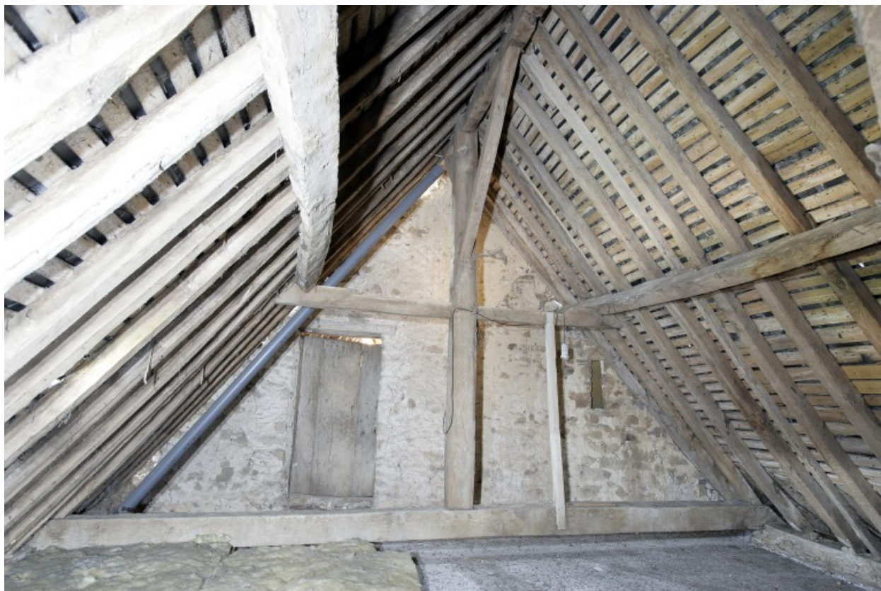
Corps sud du logis, comble : la charpente.
