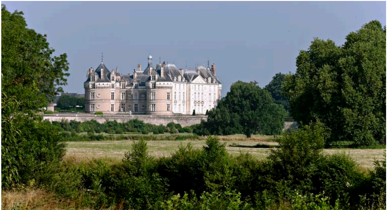
Vue d'ensemble prise du bout du parc, en amont.
