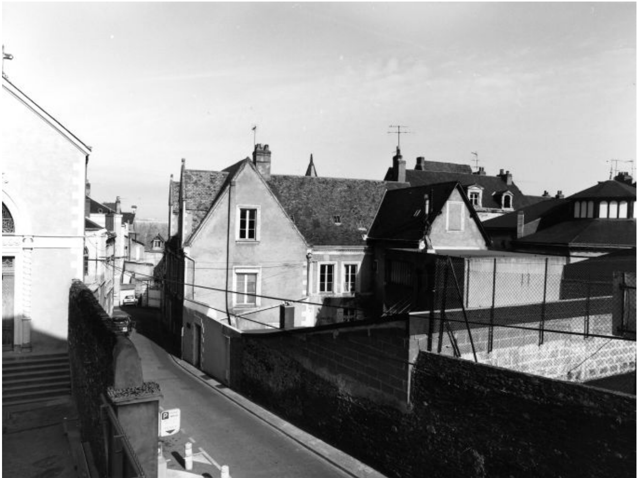
Vue de situation des arrières de l'hôtel, depuis le haut de la rue de l'Aubrière, au sud-ouest.
