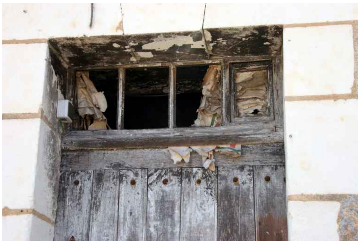
Maison n°4, détail : imposte de la porte.
