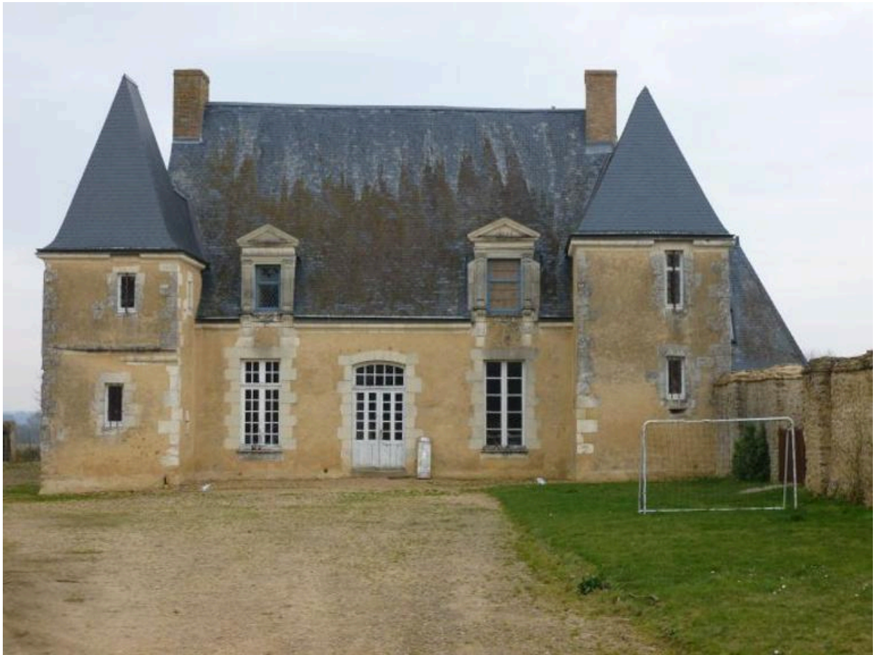
Manoir : façade sud sur cour.
