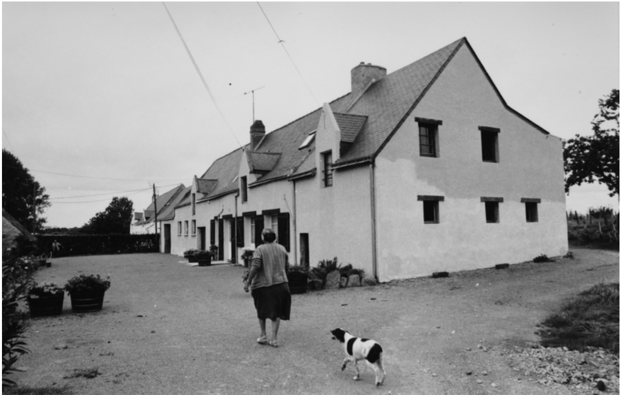
Vue de la façade sud depuis l'est.
