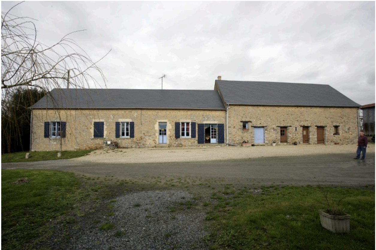
Le logis-étable vu depuis la cour au sud-ouest.
