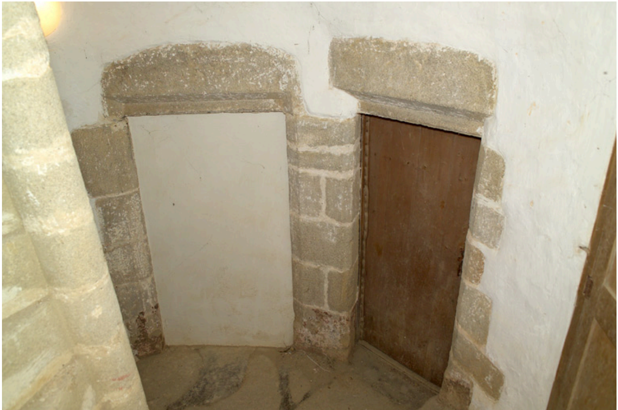
Escalier en vis, palier de l'étage, portes centrale, orientale et annexe.
