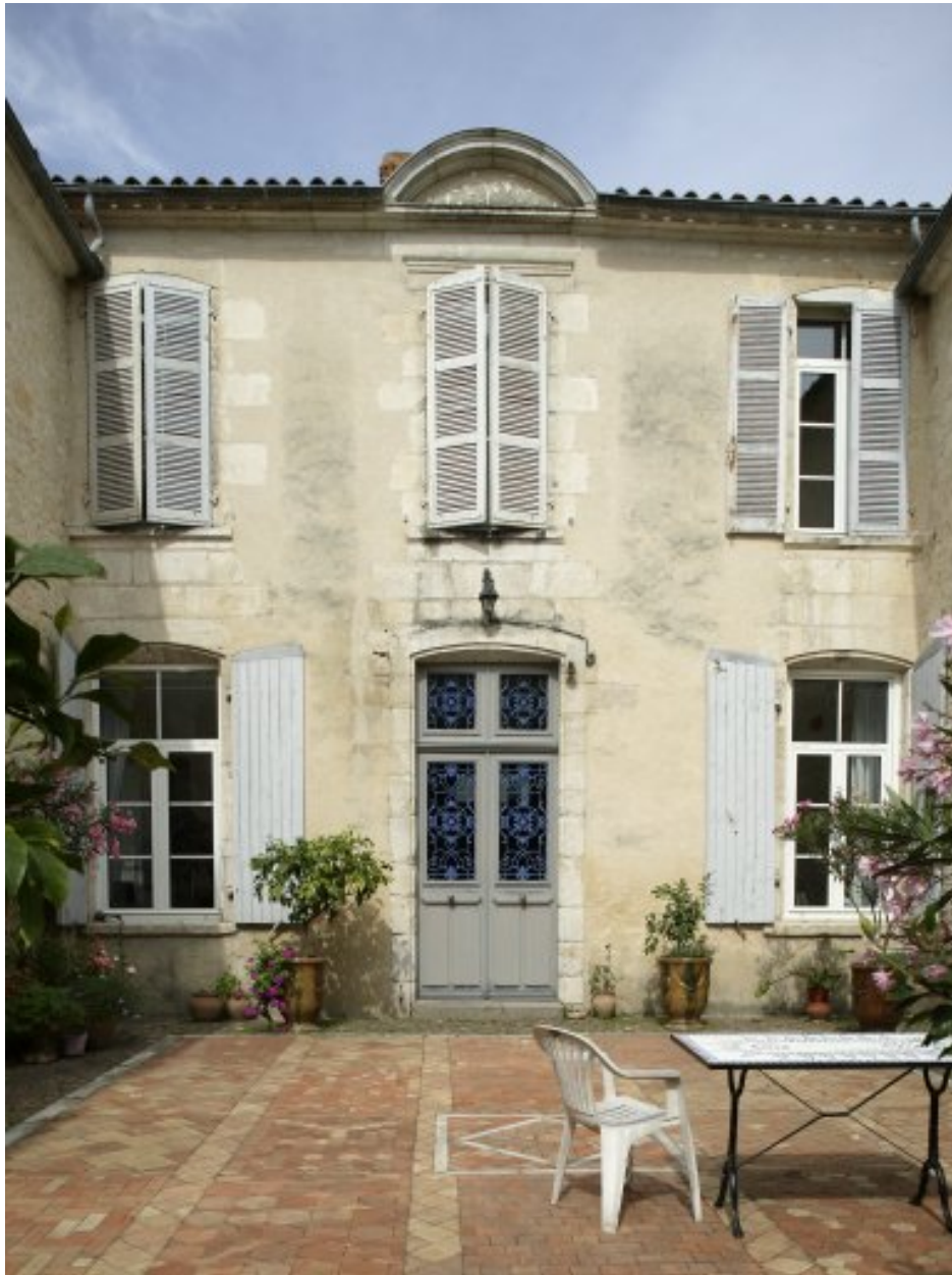
Façade postérieure du corps de bâtiment principal.
