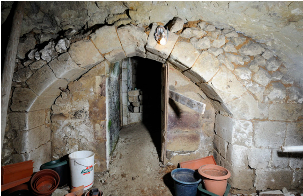
Caveau est : vue sur l'arcade d'entrée (rétrécie par des alettes et un mur, après 1693).
