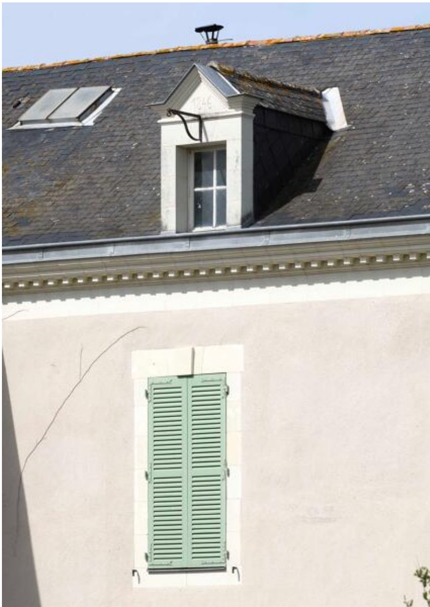
Bourg. Maison, 48 rue des Mauges, détail de la lucarne datée 1846.
