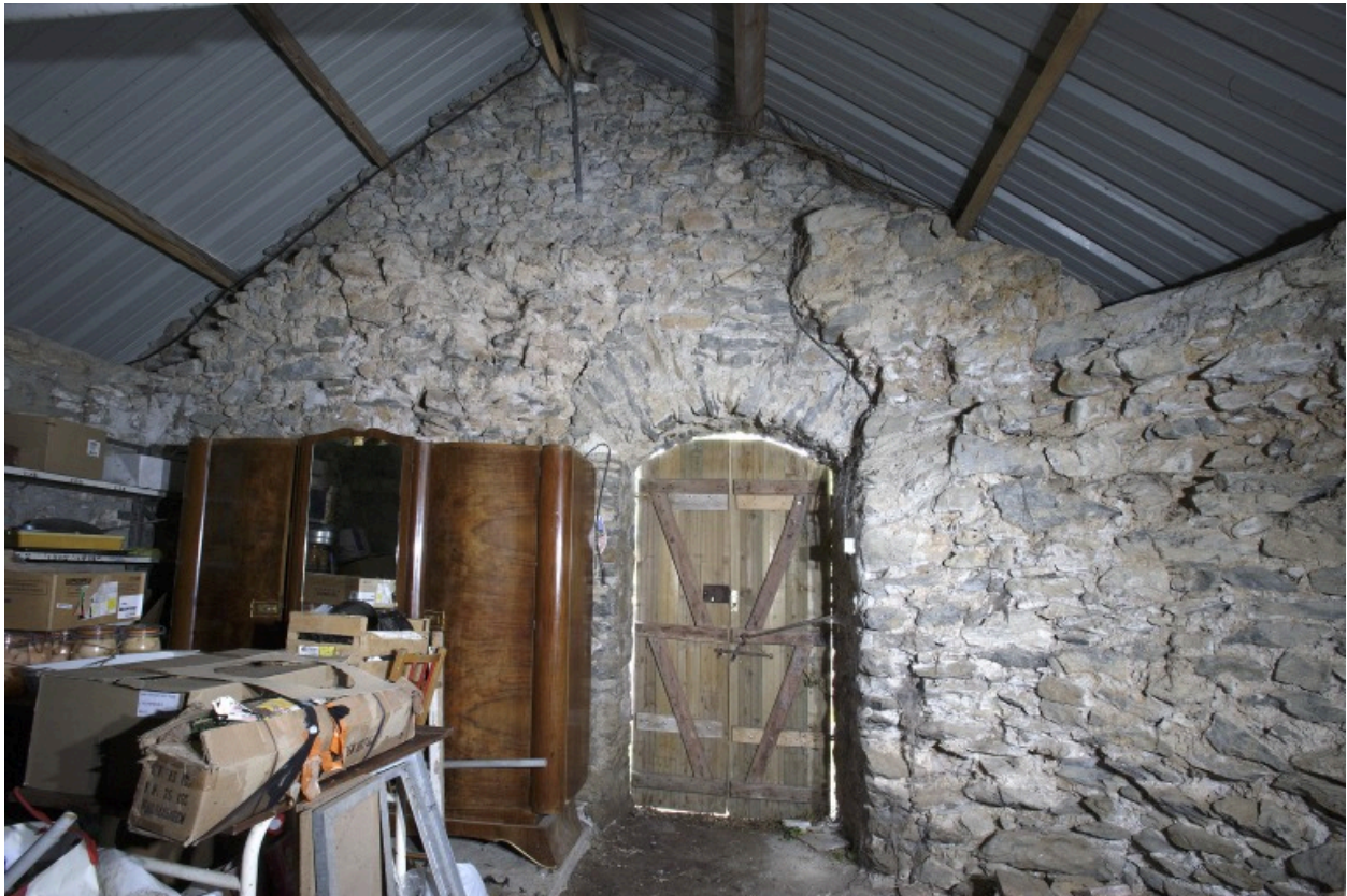
Bâtiment sud, pièce ouest : mur ouest.
