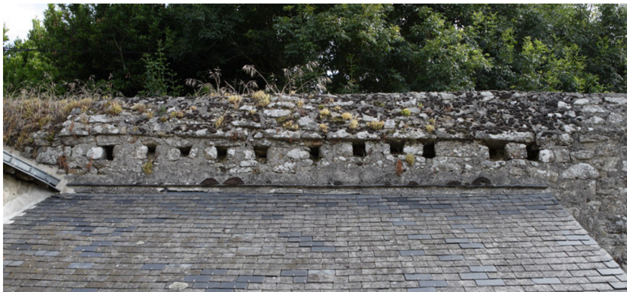
Cour. Trous de boulins au niveau du mur de clôture nord.
