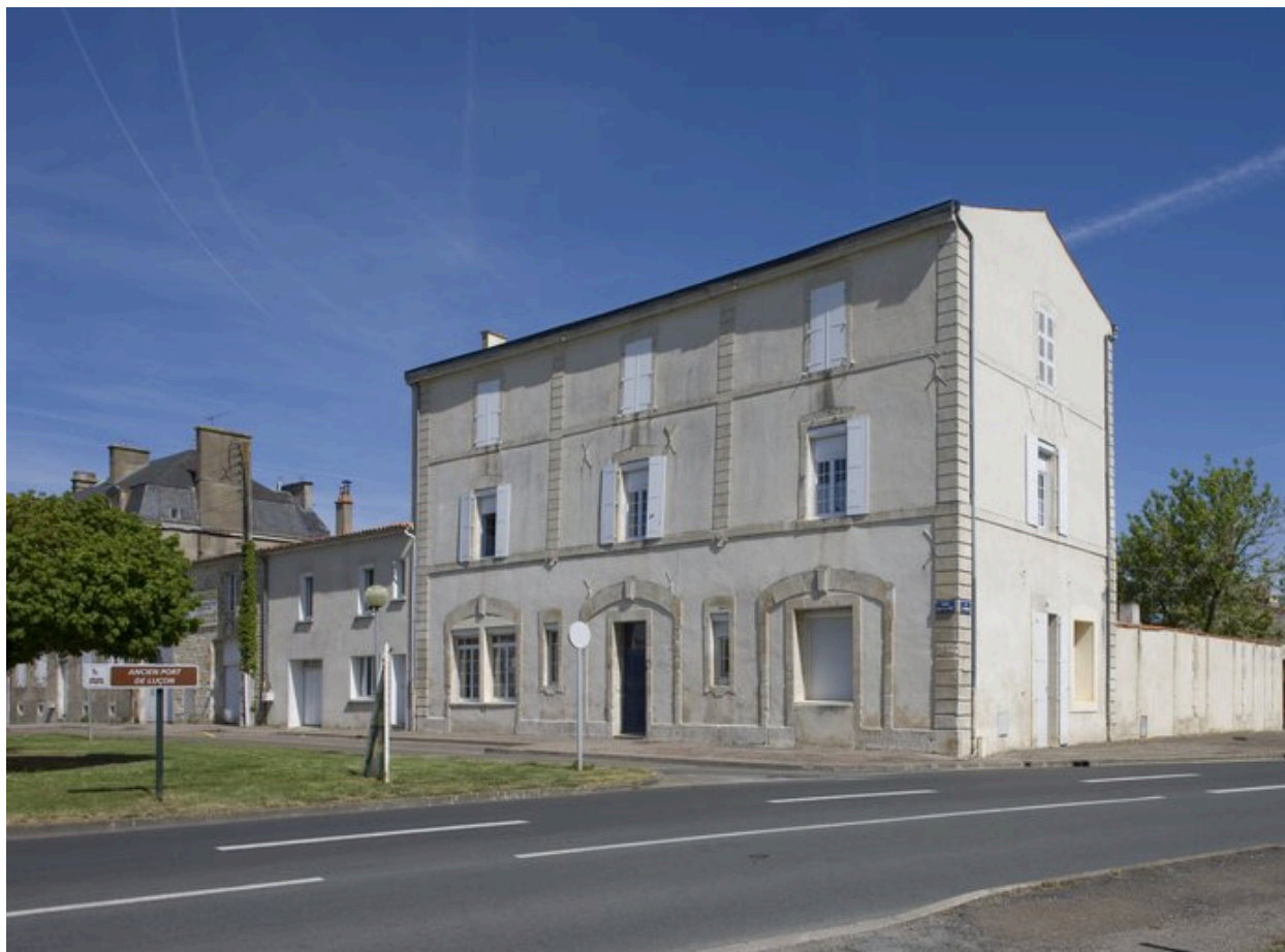
Quai nord : magasins Métereau, construits en 1865.
