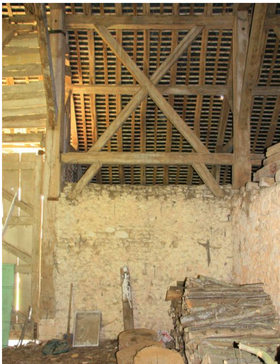
La grange : travée maçonnée entre deux poteaux des bas-côtés.
