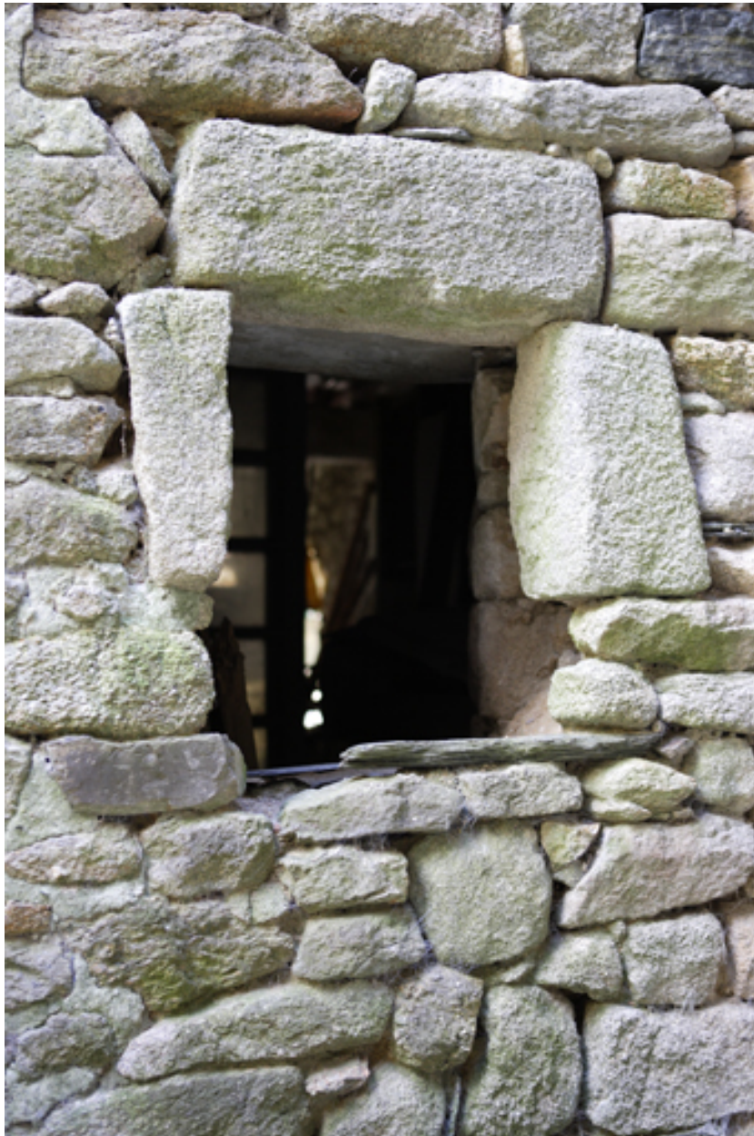
Dépendances. Détail du jour sur le pignon sud.
