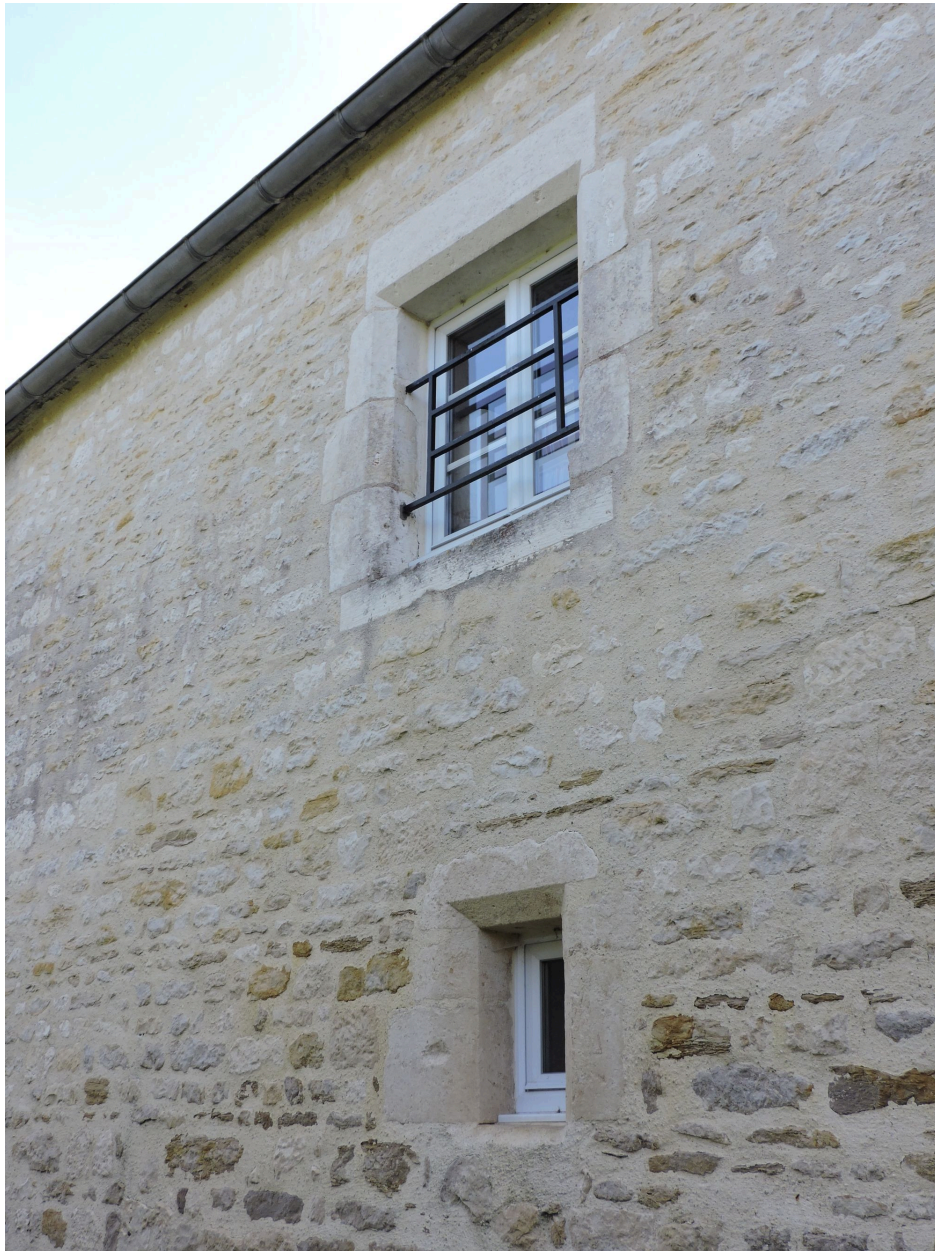
Baies à encadrement chanfreiné sur la façade nord.
