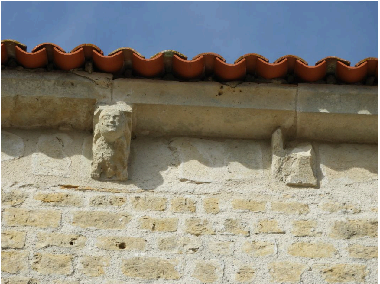
Modillons du mur sud de la nef, d'ouest en est : vue 3.
