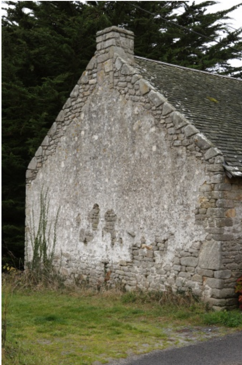
Détail du pignon remanié du n° 1.
