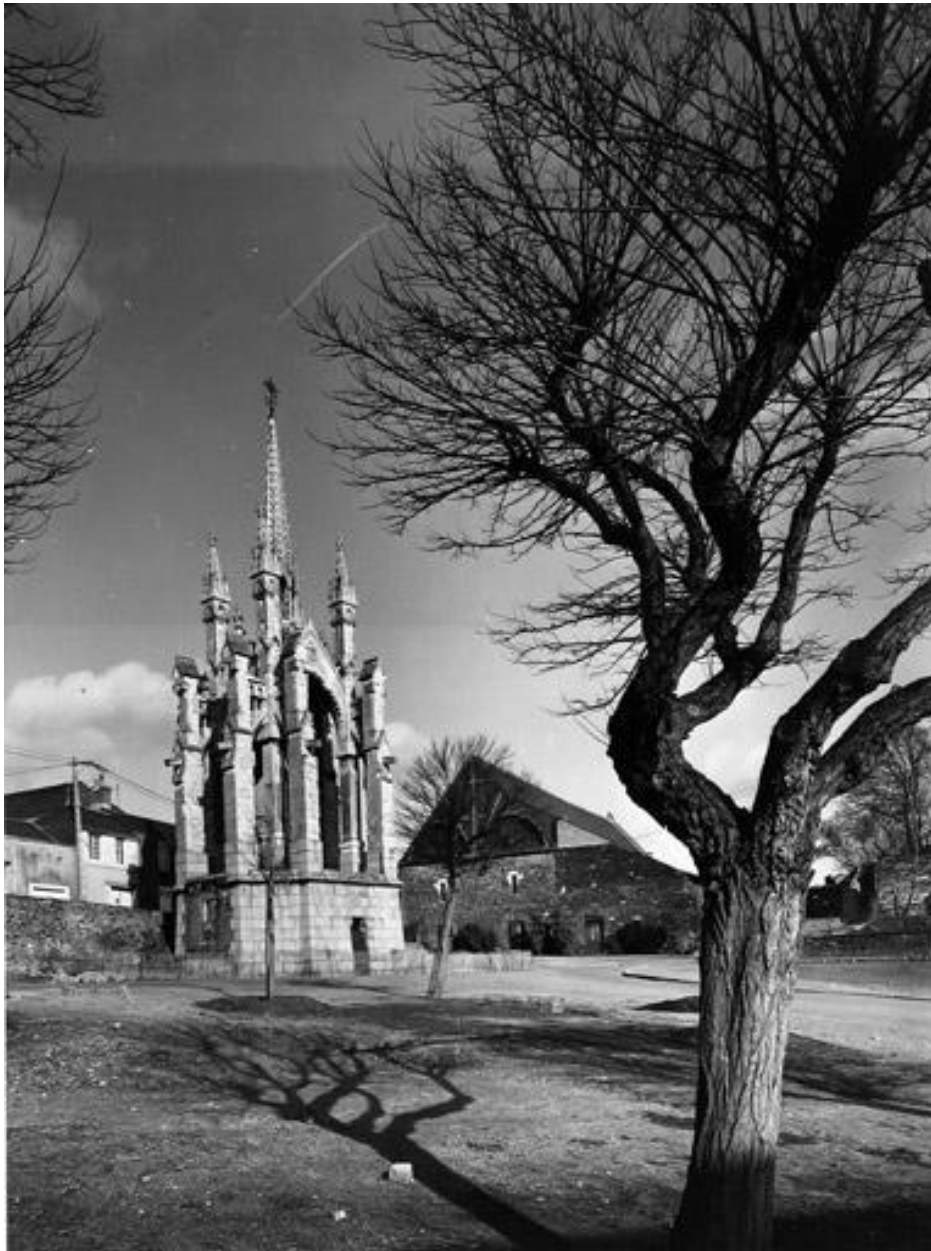
Vue de situation, au sud.
