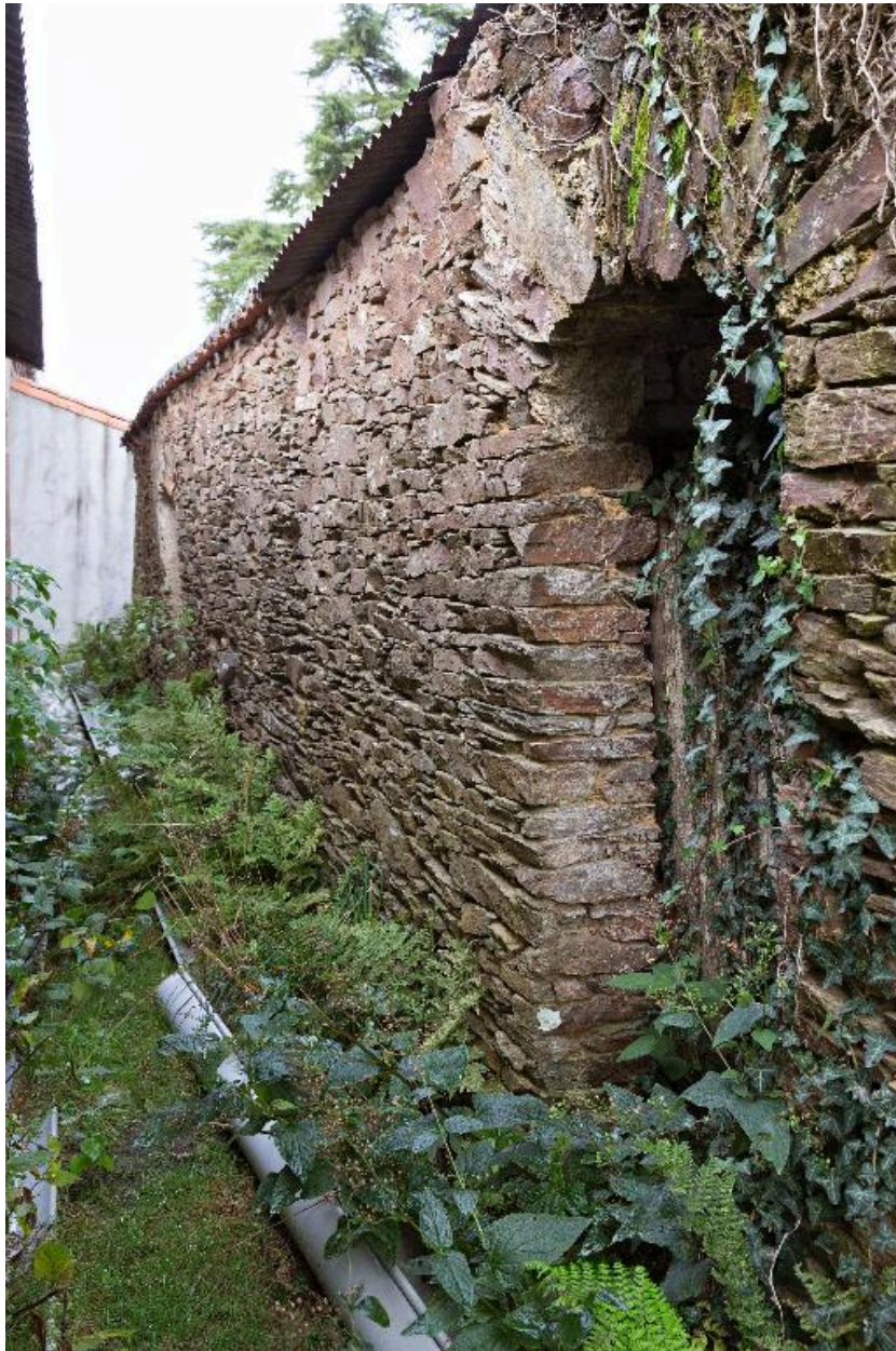
Portes à arc de schiste sur mur gouttereau postérieur de l'habitation, B01-278, cadastre 2018.
