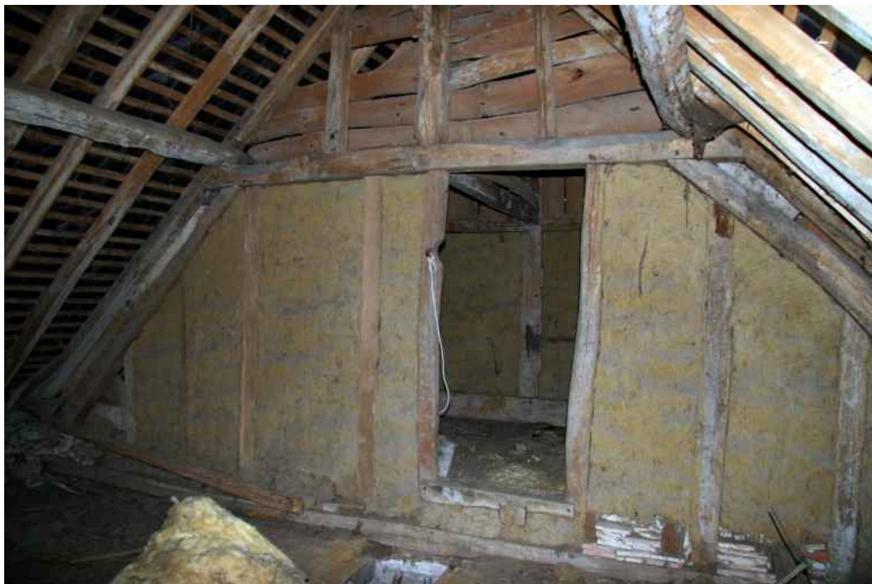
Combles : cloison en pan-de-bois au centre.
