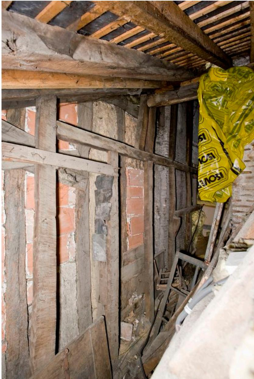
Charpente : partie supérieure de l'élévation latérale gauche en pan de bois, vue sous l'appentis latéral d'écoulement des eaux ; le pan de bois à remplissage de parpaing est le mur latéral droit de la maison voisine au n° 57.
