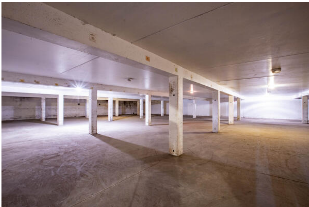
Zone de stockage des bouteilles, semi-enterrée.
