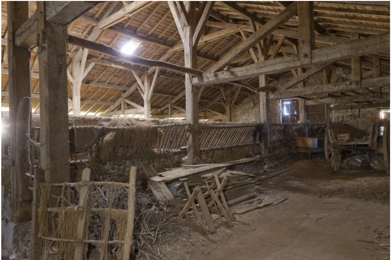
Vue de l'étable à bovins, prise en direction de l'entrée.
