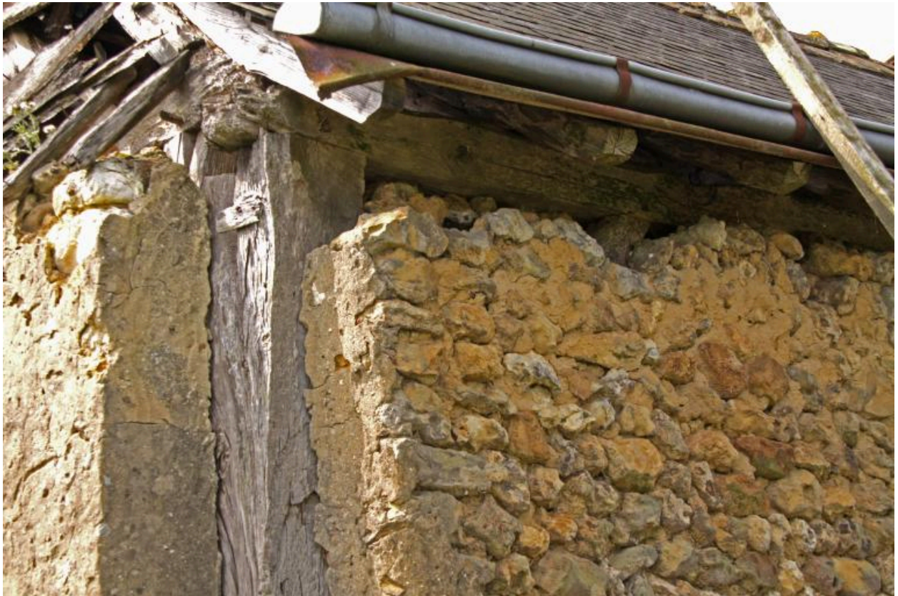
Maison 1 : détail d'un poteau de bois à l'angle des murs est et nord.
