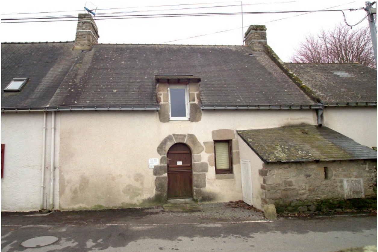
Vue de la façade depuis la rue.
