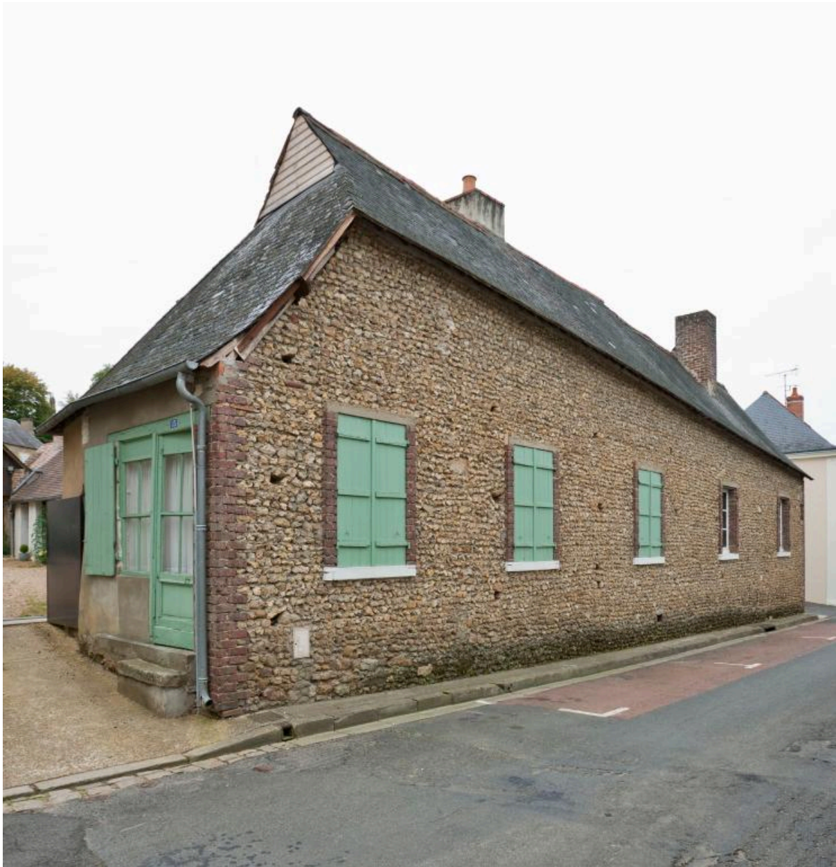
Façade sur rue mise à l'alignement, et atelier en appentis.
