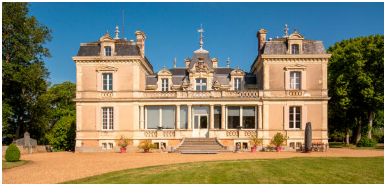
L'élévation antérieure, côté sud-est.
