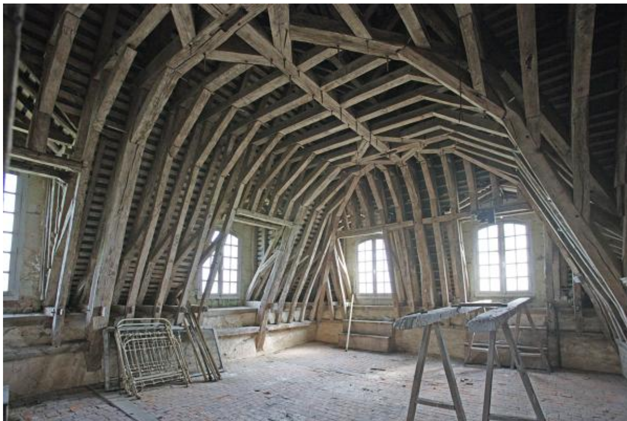
Le grand comble et sa charpente, croupe du pavillon sud.
