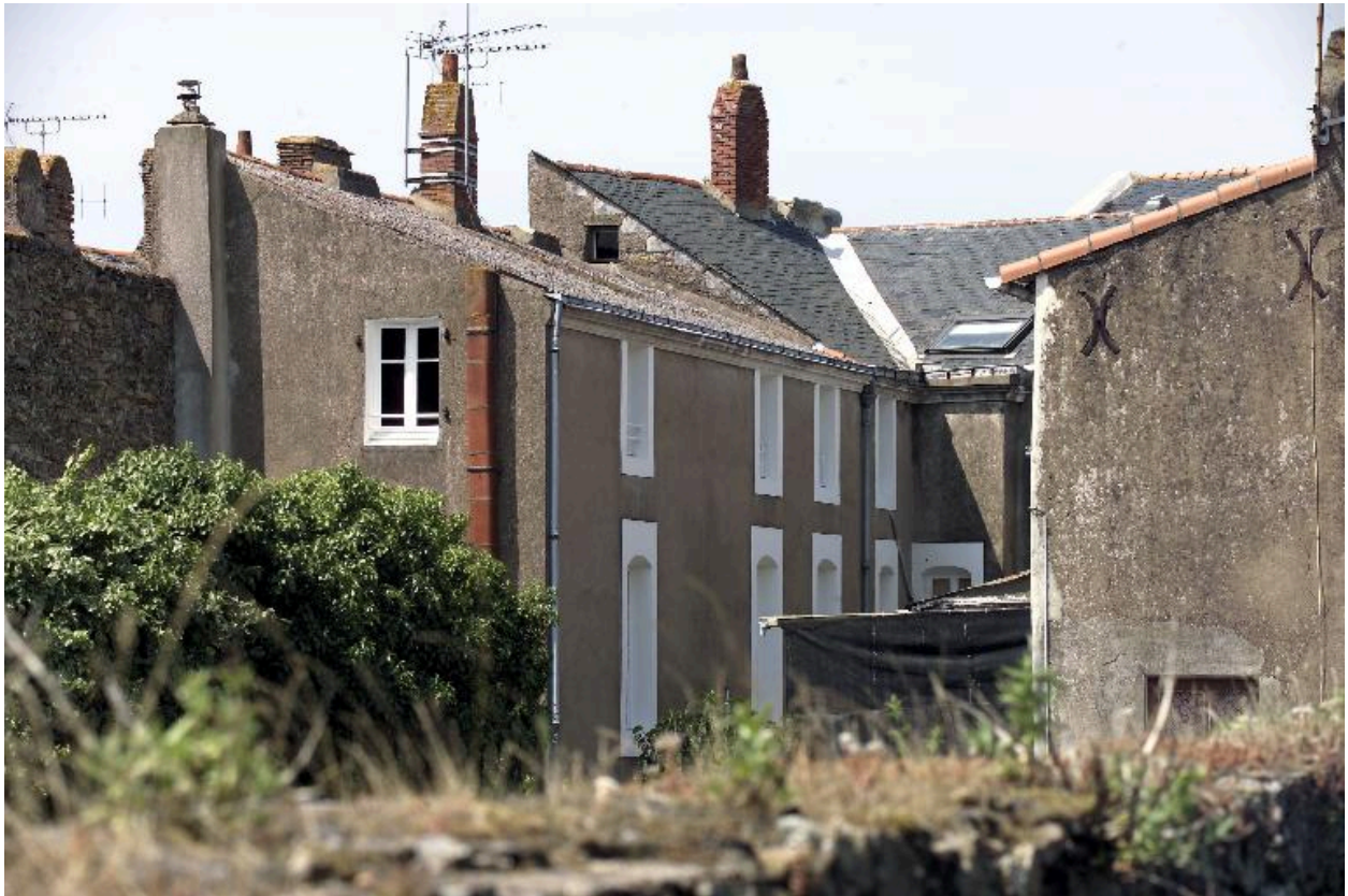
Maison, 31 rue du Général-De-Gaulle.
